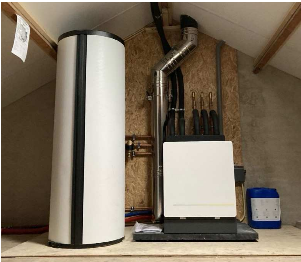
Principe opstelling technische installatie zolder
